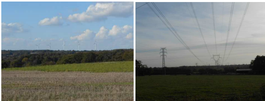
Saint-Aubin-les-Châteaux : les éoliennes s'imposent dans le paysage communal / sortie Sud du bourg – un paysage parcouru par d'importantes lignes électriques / La Gastinelais
