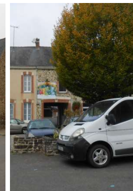
Locaux de l'ancienne école
