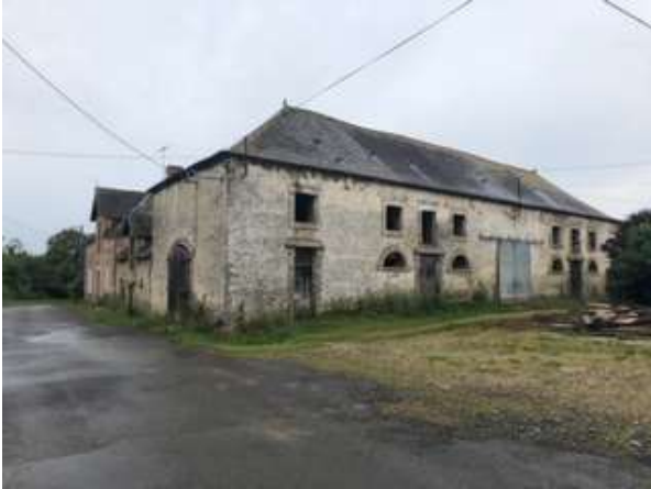
Vue sur les bâtiments actuels
