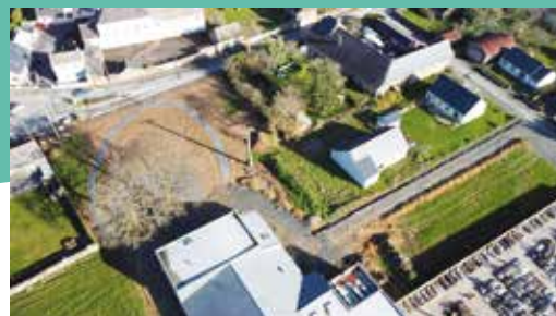
Les terrains bordant l'Espace Castella en cours d'aménagement
