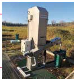
Le service d'assistance technique du Conseil Départemental a préconisé la mise en place d'un dégrilleur automatique avec compacteur sur la station d'épuration par lagunage de la commune pour éviter que l'entrée de la station ne soit obstruée.
