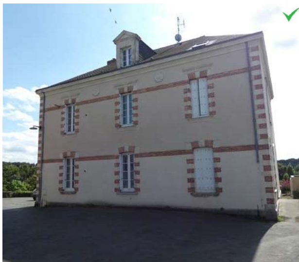
Une rénovation relativement respectueuse de l'existant Mais la perte des cheminées, l'arrivée du PVC
