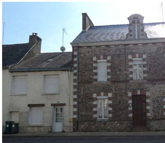
Vigilance sur les coffres de volets roulants apparents, sur les ardoises...
