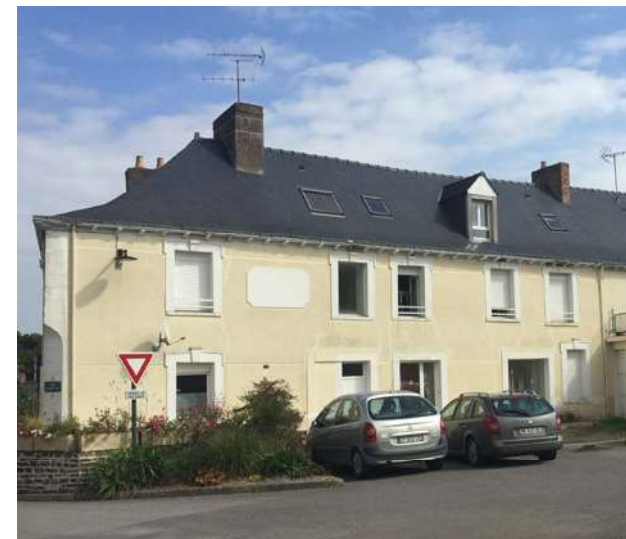
Vigilance sur les matériaux : qualité d'enduit, recouvrement des modénatures de pierre et brique, pvc... Vigilance sur la composition des ouvertures : lucarne non alignée, isolée...
