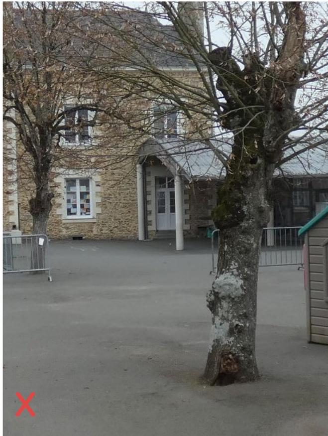
Un enrobé jusqu'en pied de l'arbre = risque fort de dépérissement à terme et dégradation du revêtement
