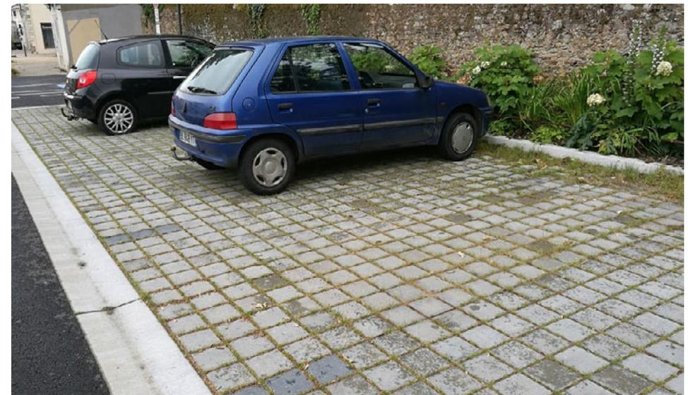
Geneston (44) - Stationnements requalifiés en pavés joints perméables - Ajout de massifs de mise à distance
