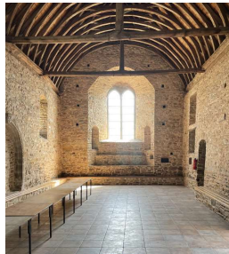
4 - VUE INTÉRIEURE DE LA CHAPELLE MURS PIERRE / CHARPENTE BOIS
