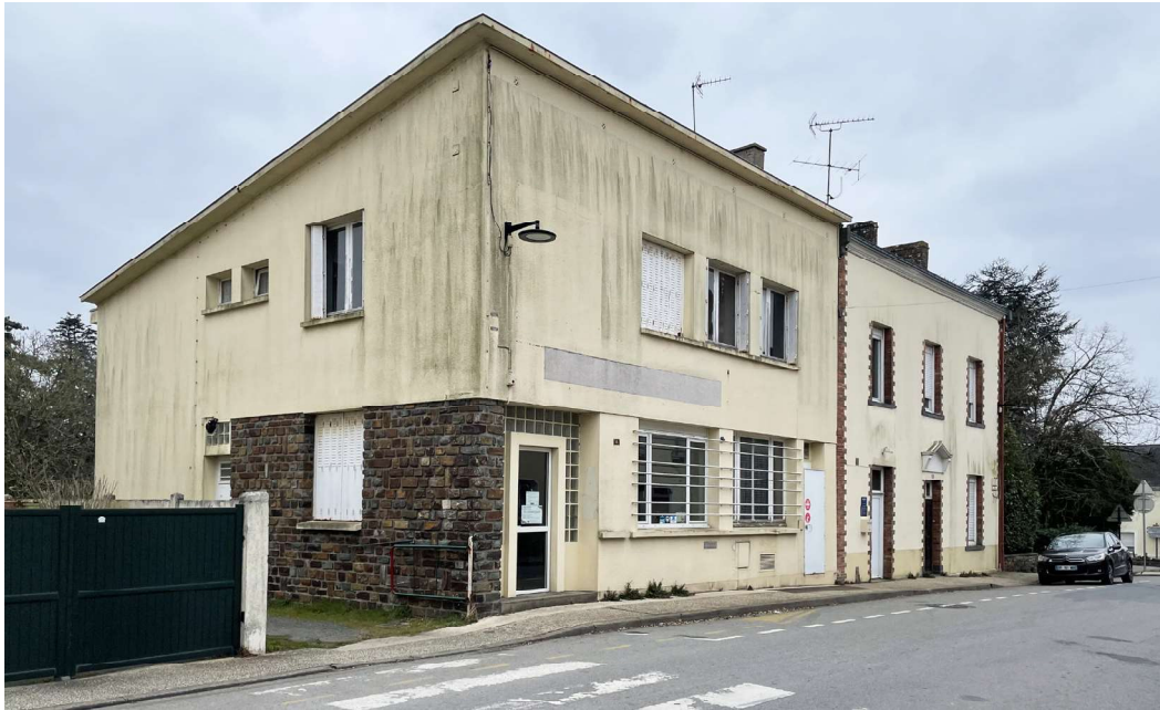
1 - VUE DE L'ANCIENNE POSTE - COTE RUE
