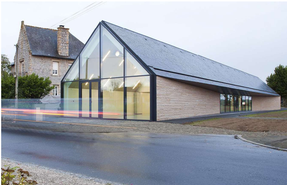
Un nouvel équipement identifiable depuis la rue 56S ARCHITECTES - EQUIPEMENT
