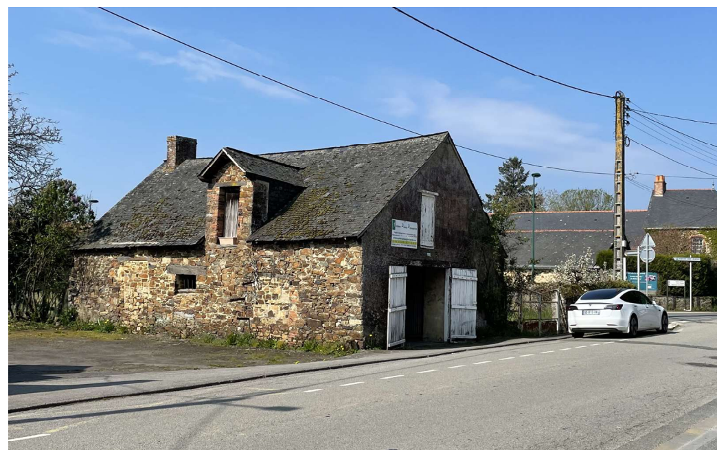
ENTRÉE DU SITE
